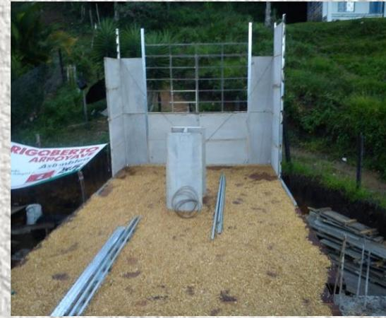
Fotografía, fuente: Fotografía tomada por Ivan Dario Barriga, integrante del equipo de trabajo en la vereda Juan Cojo en Copacabana, Antioquia, recurso de estudio para esta investigación, el uso del vaciado de columnas con formaleta y muros en losas prefabricadas.
