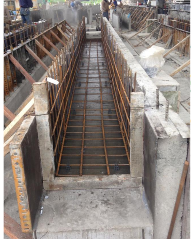
Estructura de formaviga puesta en banco
