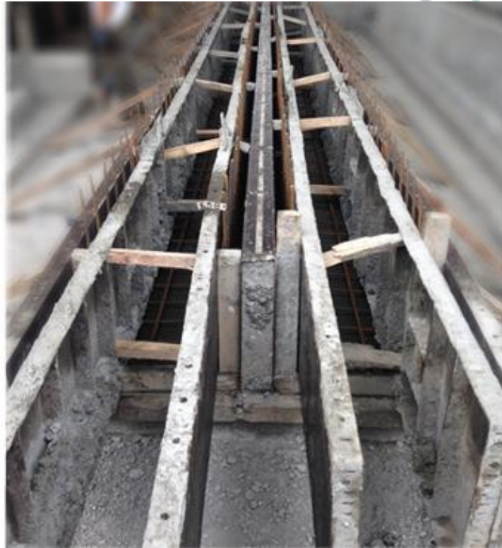
Banco con viga lista para vaceado
