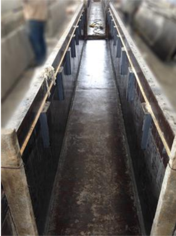
Preparación banco (formaleta) con aligerantes
