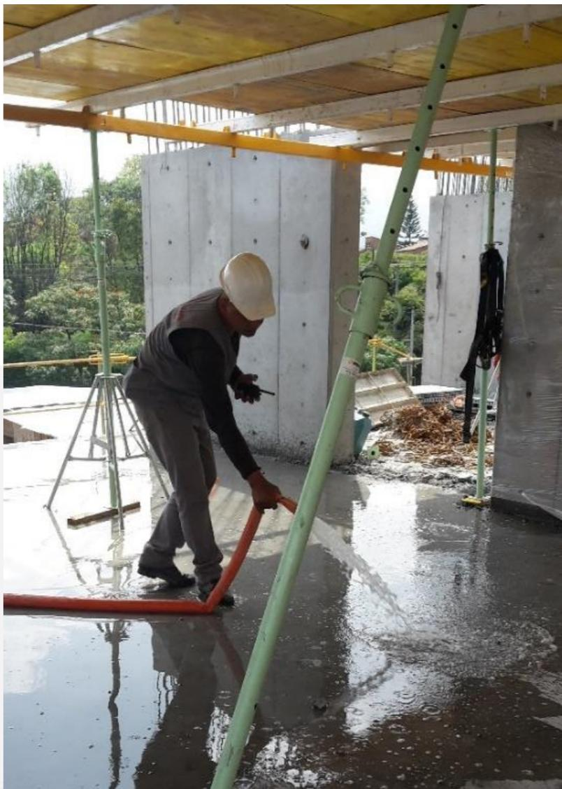
**PROCEDIMIENTO: CURADO DE CONCRETO EN LOSAS DE 3.000 PSI CON AGUA SUBTERRÁNEA IMPULSADA CON ELECTROBOMBA DE 7.5 Hp.**
