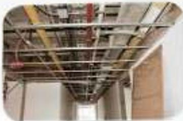
Al realizar el inicio de la instalación de un cielo falso se debe de procurar el perfecto estado de las redes a instalar en la estructura para evitar reproceso y daños luego de su instalación
