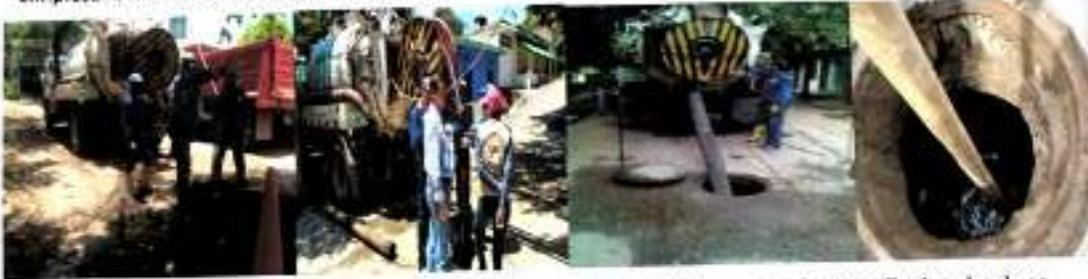
**LIMPIEZA RED ALCANTARILLADO PLUVIAL (Limpieza de las cámaras de inspección de aguas lluvias, donde se retira tierra, por la falta de pavimentación, conduciendo estos sedimentos cada vez que se presenta las lluvias).**
