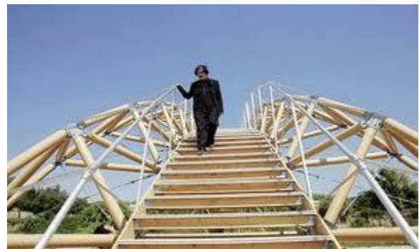
Puente sobre el rio Gardon en Francia en el 2007 Foto tomada de Google.com
