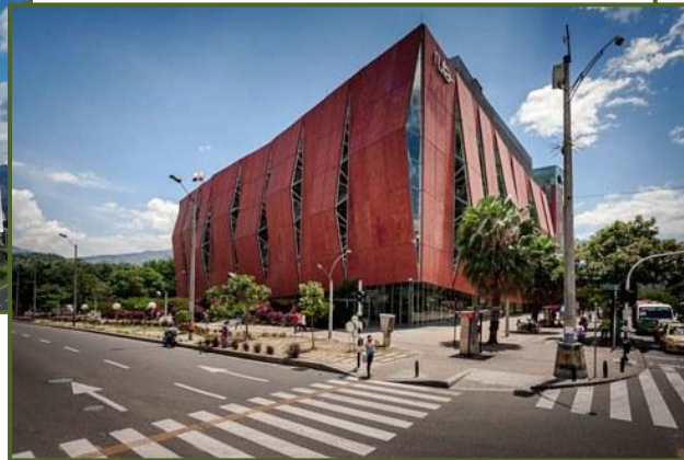
Edificio Ruta N
