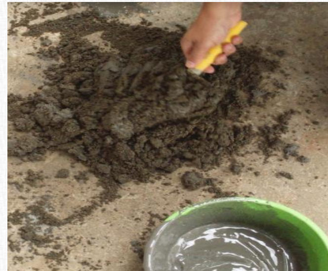
Figura 5: Fotografía preparación revoque tradicional – Fuente propia.
