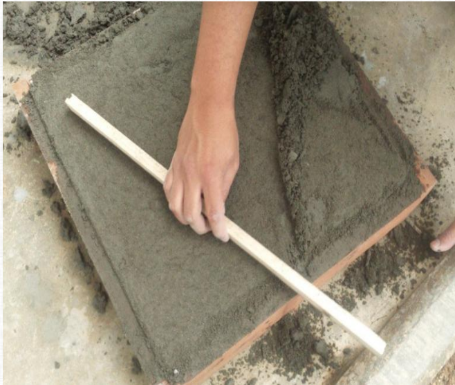
Figura 6: Aplicación del revoque – Fuente propia.
