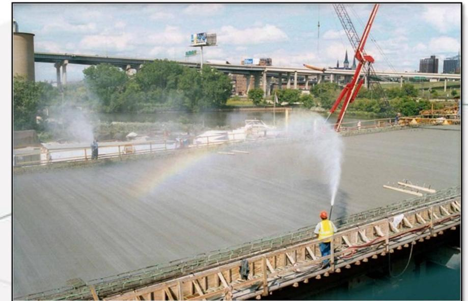
Foto 7. Losa durante proceso de curado por aspersión
