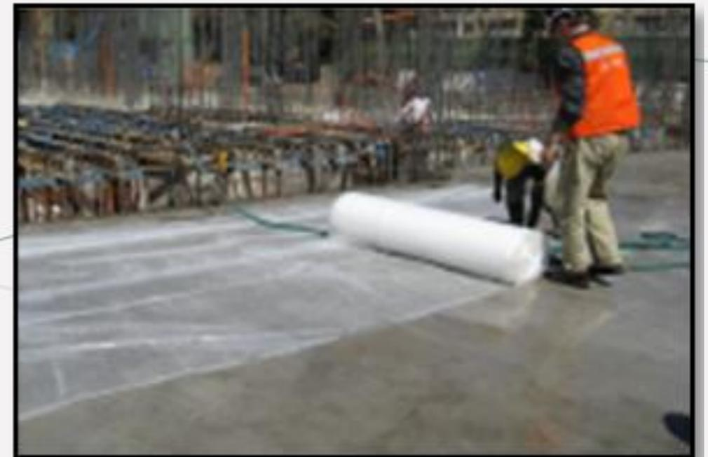
Foto 8. Losa durante proceso de curado con material sellante
