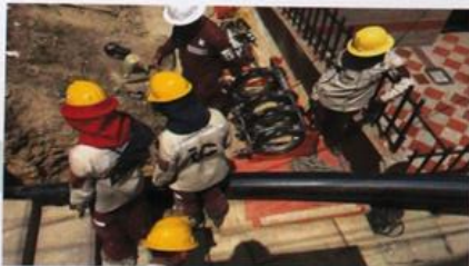
Sistema pipe bursting. Fuente: SEDIC S.A.
