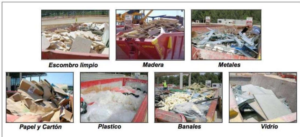
**Figura 1.** Tipos de escombros generados en obra. Fuente: Recuperado de [http://ambientebogota.gov.co/en/c/document\\_library/get\\_file?uuid=9501675e-042c-46b4-90c9-639f6cd07598&groupId=664482](http://ambientebogota.gov.co/en/c/document_library/get_file?uuid=9501675e-042c-46b4-90c9-639f6cd07598&groupId=664482)
