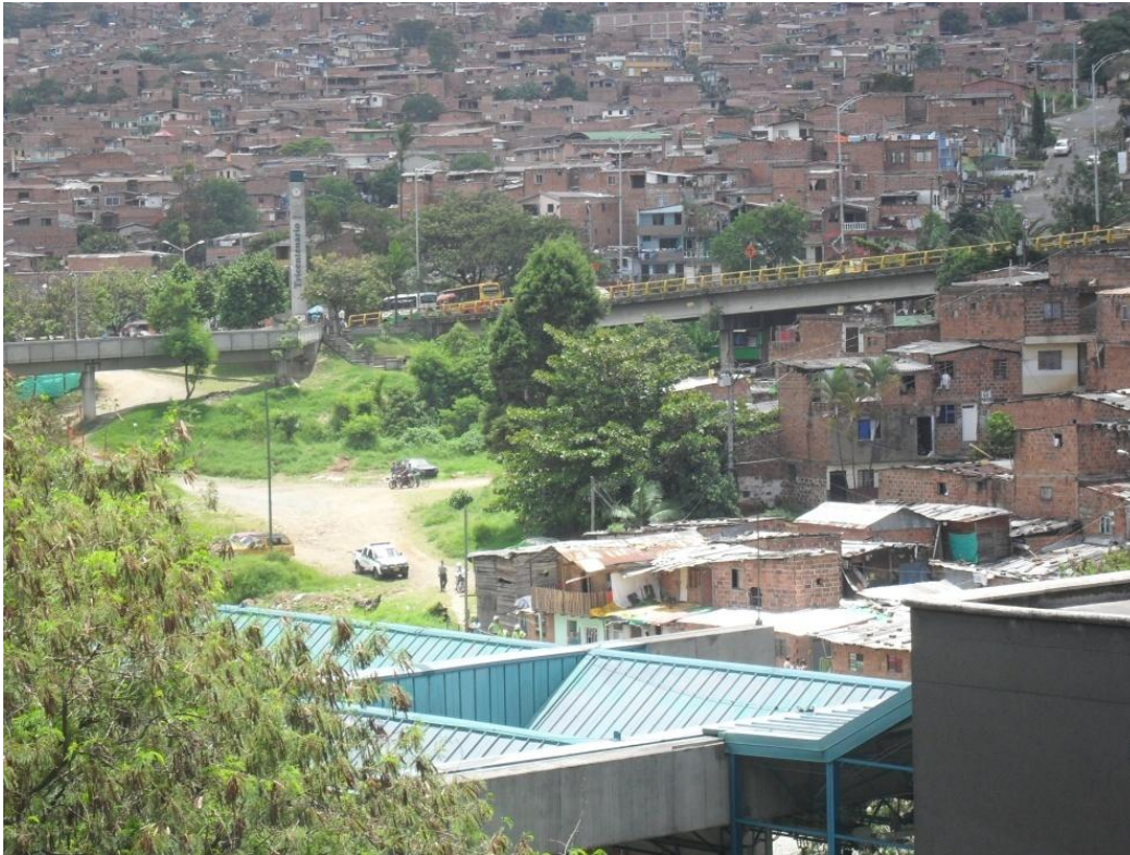
Problemática: viviendas a orilla del río.
