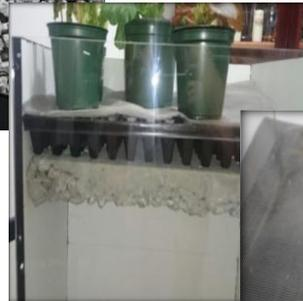
**Sistema de drenaje:** se coloca el sistema de drenaje para la recolección de las aguas lluvias con una pendiente del 3% para garantizar que el agua evacue
