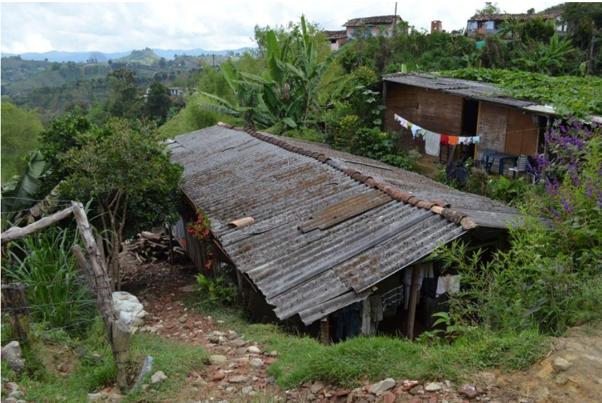
Fotografía: Santiago Rodríguez Restrepo Techos-1. 29/10/2012 – 11:38 a.m.
