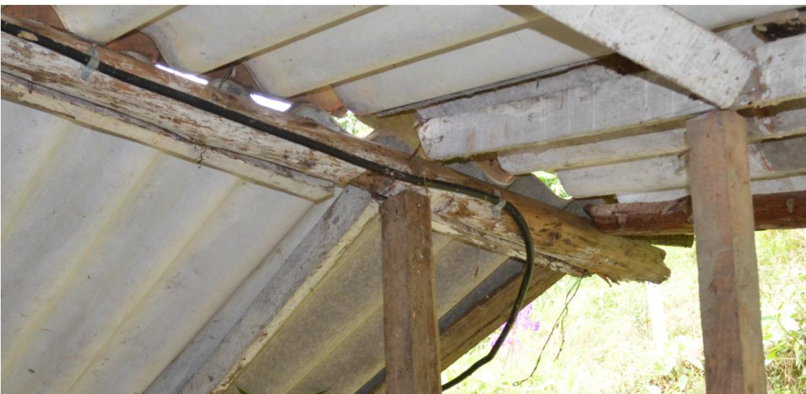
Fotografía: Santiago Rodríguez Restrepo cerchas-3. 29/10/2012 – 11:44 a.m.
