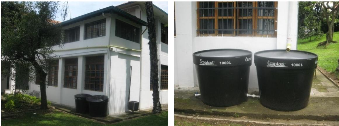
Figura 2. Sistema piloto de captación y almacenamiento de agua lluvia en la I.U. Colegio Mayor de Antioquia.
