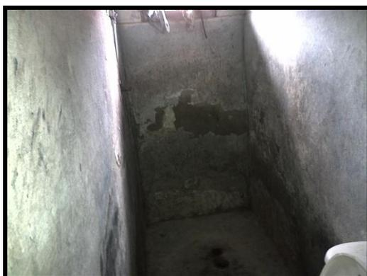
Como podemos observar en la imagen, el baño no posee ningún tipo de recubrimiento impermeabilizante como lo es un enchape o alguna pintura epóxica. Por lo tanto es una causa generadora de una humedad por filtración a las zonas vecinas, causando erosión en el mortero de revoque, evidenciado en la segunda
