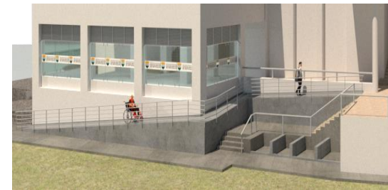
Adecuación rampa peatonal edificio patrimonial
