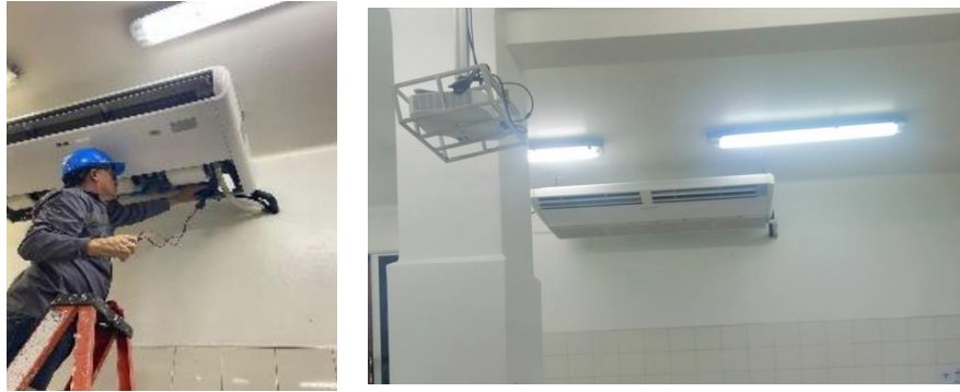
Fotografía 8. Mantenimiento de aires acondicionados.
